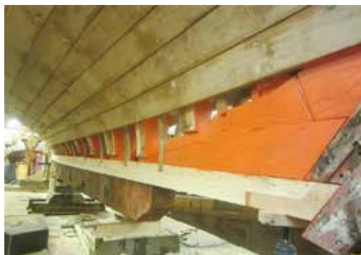
Ny trekjøl og øvre del av jernkjølen er på plass i lykkelig gjenforening. Foto Risør Trebåtbyggeri
