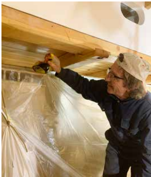
Vinterdugnad. Fredrik oljer undersiden av det nye dekket.
