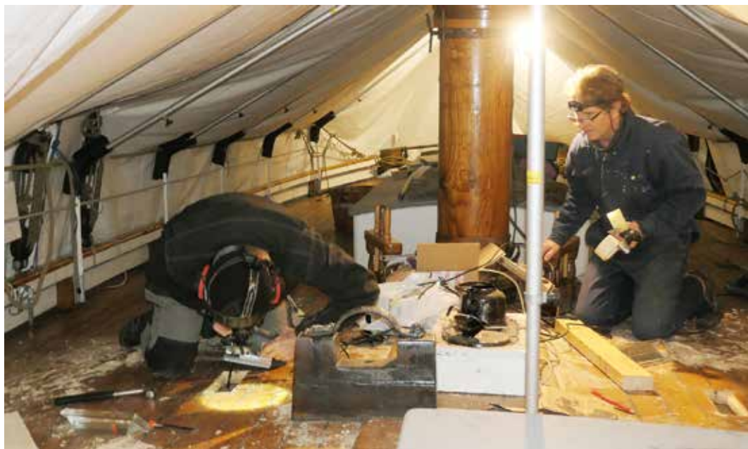
Fredrik beundrer Øyvinn som legger inn i lysprismer i dekket over byssa.
