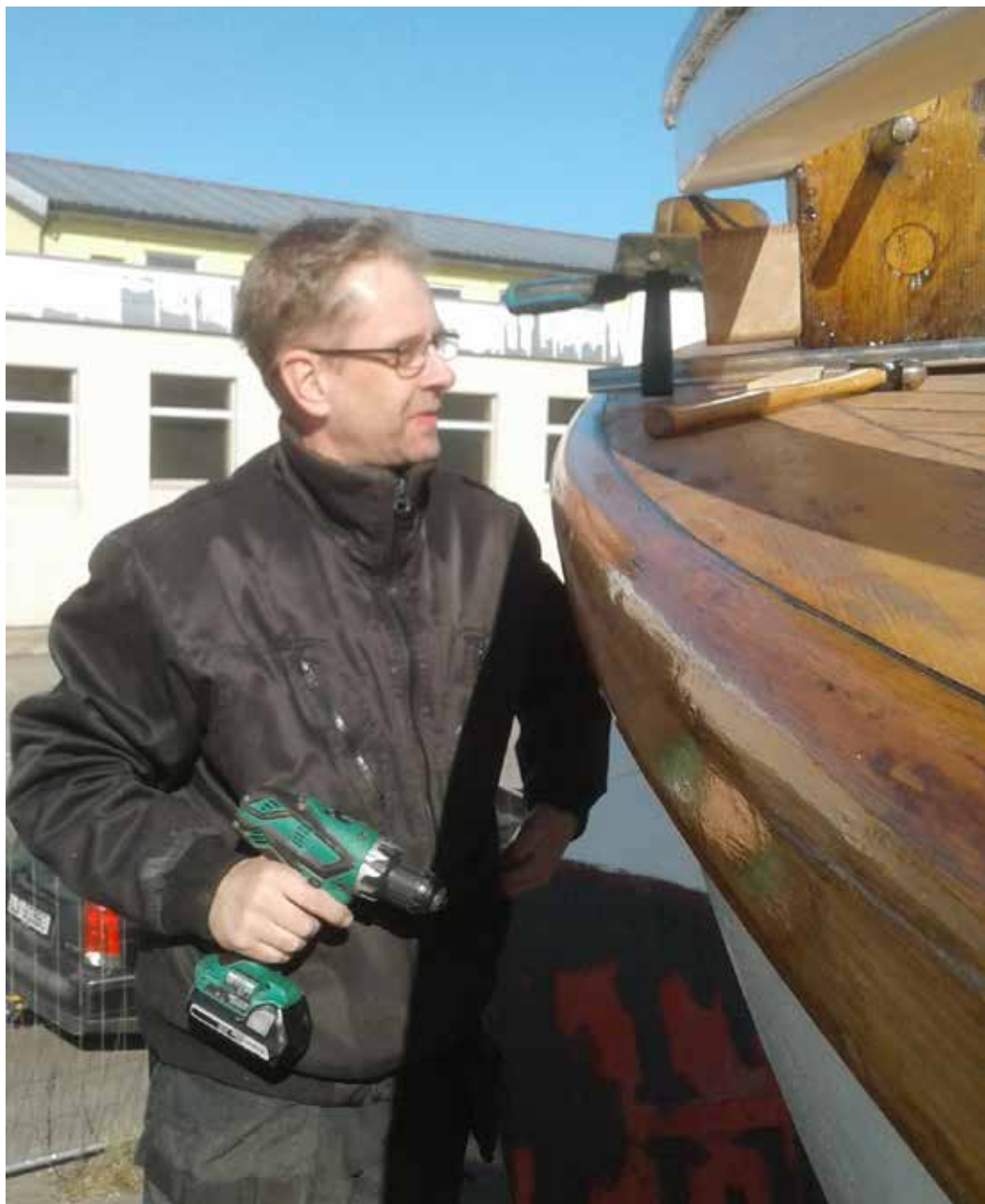
Driftssjef Thor Ivar Gulliksen monterer nytt rekkebord.
