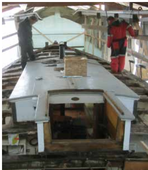
Dagens store kappe som ble bygd på Hvasser i 1942/43.
