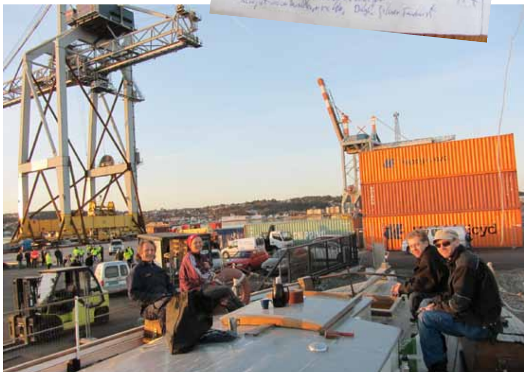
Larvik Havns nye containerkran bukses på plass under kaffepausen.
