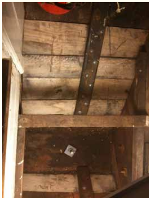
Nye bord er på plass i baugen.
