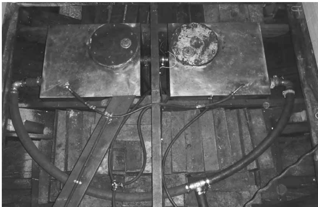
Dieseltankene har fått nye inn- og avløp.
